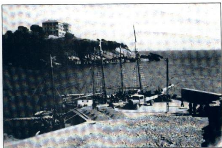
Motiv gataš ndërtimit të molos Motiv tokom gradnje skele Motive during the construction of the port
