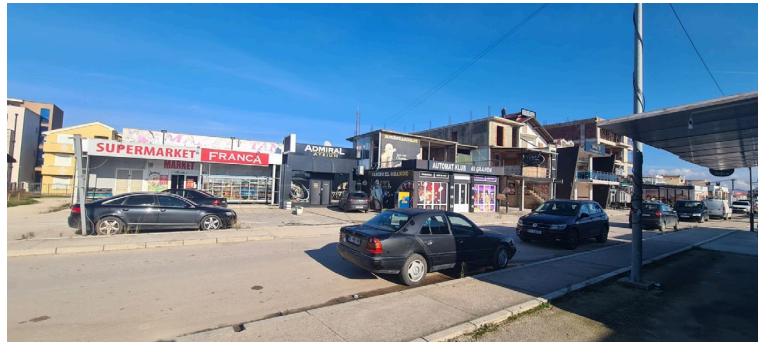
Slika 2.3. Izgled užeg okruženja lokacije
