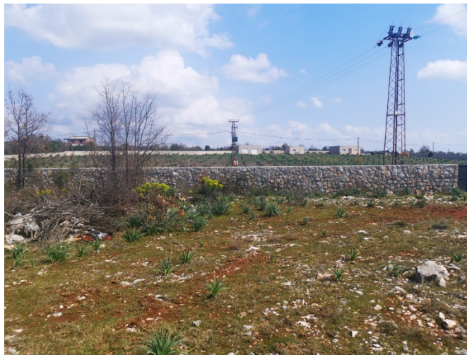
Slika 1. Pristup predmetnoj lokaciji na kome se gradi Rasklopište
