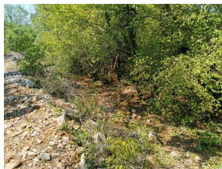
Slika 8 - Postojeće stanje južnog dijela nasipa Sv.Nikola-Reč
