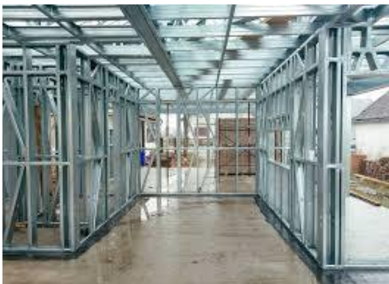
Slika 1. Primjer panela izrađenih od "C" profila od pocinkovanog čelika
